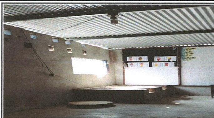
Foto 14: Colocación de campana y remodelación de polietileno
